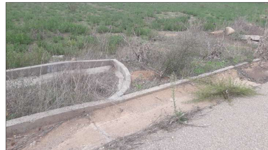
Foto 5 - Particolare cordonata stradale/marciapiede in prossimità degli accessi
