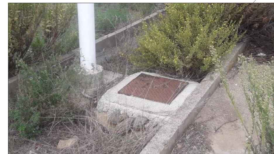
Foto 8 - Particolare pozzetto di derivazione e palo con armatura stradale
