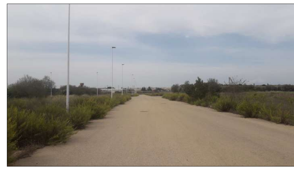
Foto 1 - Particolare strada di piano - Vista nord-ovest
