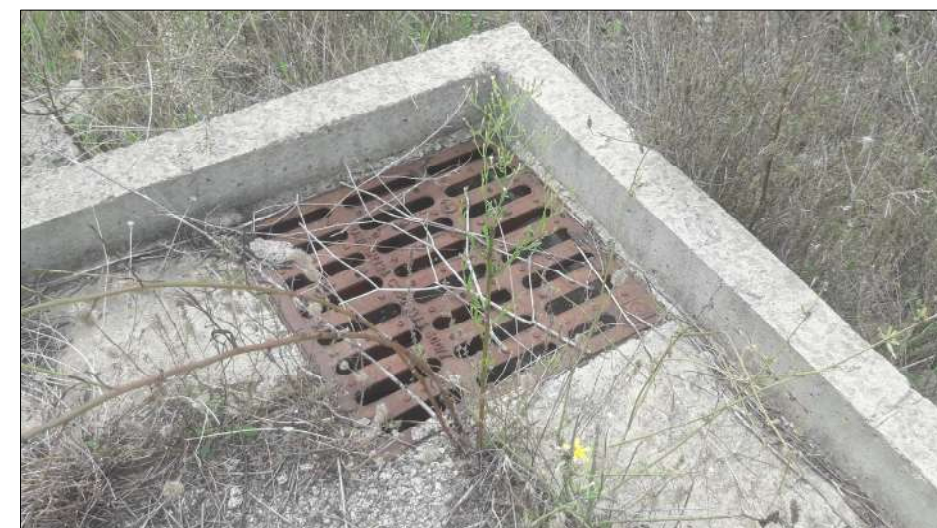
Foto 7 - Particolare caditoia per acque meteoriche
